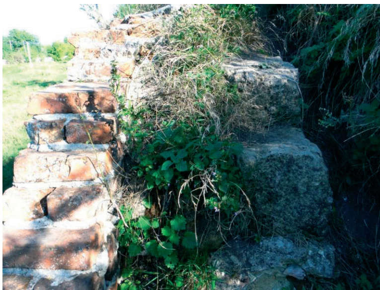
Rys. 7. Dwówarstwowa konstrukcja zewnętrznej ściany kurtyny w miejscu zrujnowanego fragmentu obronnego muru: starsza kamienna część (z prawej) i młodsza okładzina z cegły (z lewej). Foto: M. Bezv, 2014.
