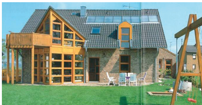
Rys. 2. Przykłady wykorzystania niekonwencjonalnych źródeł energii w domach na terenach wiejskich: a) małe elektrownie wiatrowe [19], b) duże elektrownie wiatrowe [20], c) aktywne wykorzystanie energii słonecznej [21], d) pasywne wykorzystanie energii słonecznej [22]
