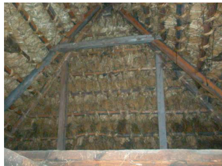
Fot. 2. Konstrukcja dachu chałupy z Błonia
