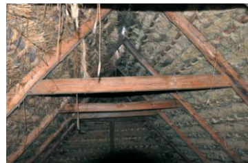
Fot. 4. Konstrukcja dachu chałupy z Brzezin
