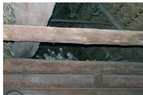
Fot. 10. Konstrukcja dachu Okólnika z Żabna
