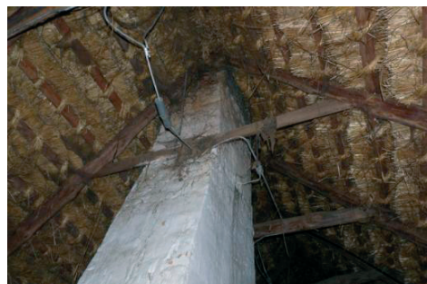
Fot. 12. Konstrukcja dachu chałupy z Niemiec
