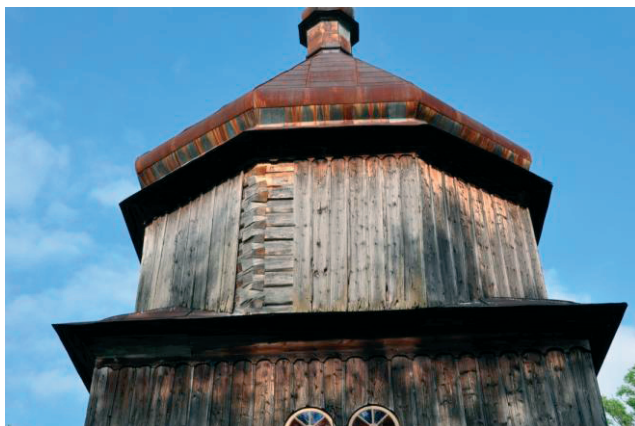
Fot. 5. Szalunek z desek jako forma ochrony zrębu budowli, a szczególnie połączeń ciesielskich. Kilkostopniowe okapy odprowadzające wody opadowe od elewacji zastępujące rolę rur spustowych
