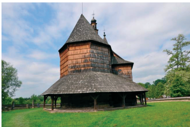
Fot. 6. Soboty osłaniające podwalinę i dół zrębu, odprowadzające wody opadowe od fundamentów, jednocześnie zapewniające cyrkulację powietrza wokół budowli
