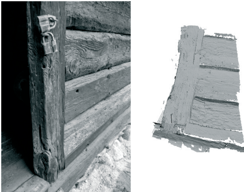
Ryc. 10. Fragment przykładowej ściany zewnętrznej budynku drewnianego z zachowaną plastiką oraz śladami obróbki (po lewej) oraz wizualizacja modelu 3D (model cieniowy) powstałego na bazie pomiarów skanerem optycznym (po prawej) – widoczna rejestracja geometrii, z zachowaniem szczegółów powierzchni mierzonej. Muzeum Wsi Radomskiej. [ Fot. i oprac. R. Zapłata]
