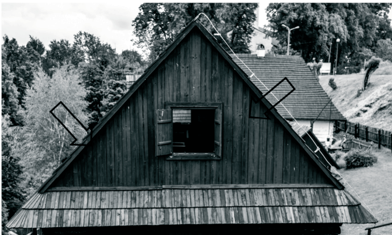
Ryc. 7a. Ściana szczytowa budynku drewnianego (dom pogrzebowy). Skansen w Dobczycach. [Fot. R. Zapłata]
