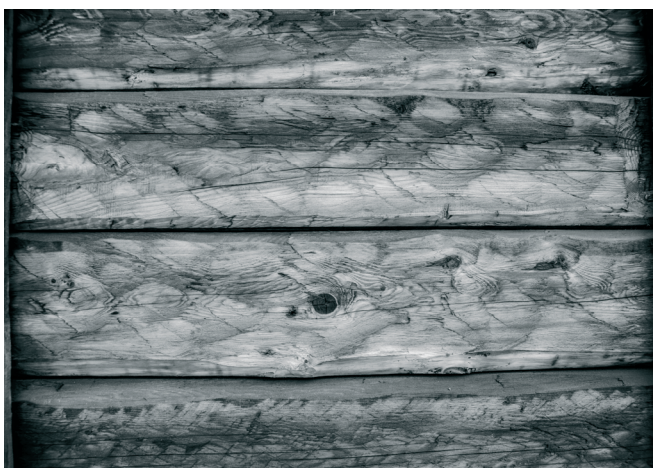
Ryc. 8a. Przykładowa powierzchnia zewnętrznej ściany budynku drewnianego, z zachowanymi i widocznymi śladami po ręcznej obróbce surowca. Przykład powierzchni o dużym potencjale dla badań traseologicznych. Spichlerz dworski ze Złotej z 1719 r. - Muzeum Wsi Kieleckiej. [Fot. R. Zapłata]
