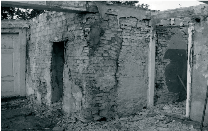
Rys. 15. Zagroda z Kaniczek, stan przed rozbiórką, podstawa komina butelkowego z widocznym zamurowanym przejściem do czarnej kuchni oraz z ścianą działową sieni po prawej stronie, fot. A. Maślak
