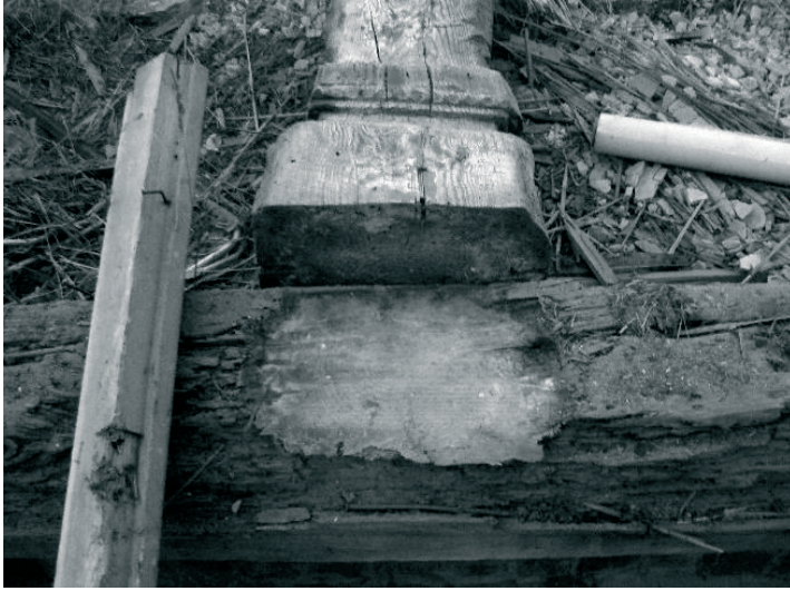
Rys. 14. Zagroda z Kaniczek, stan przed rozbiórką, połączenie słupa wystawki podcieniowej z podwaliną, fot. A. Maślak
