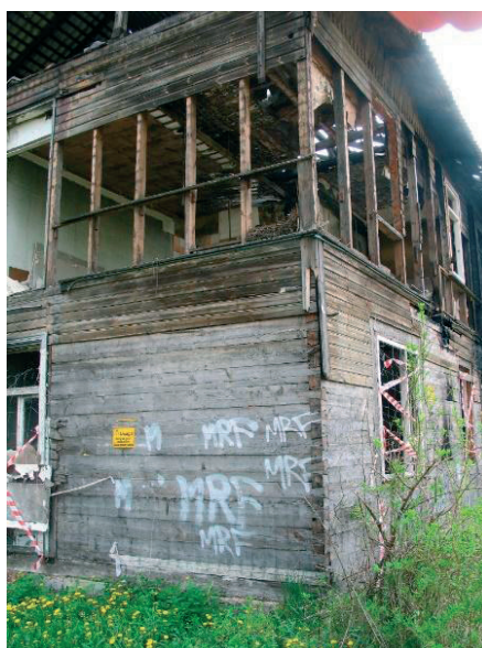
Fot. 2. Konstrukcja ściany jednopiętrowego budynku w tzw. stylu nadwiżżańskim w Radości – na parterze sumikowo-łatkowa kombinowana ze zrębem w węgle, na piętrze szkieletowa (budynek w trakcie rozbierania) – fot. A. Krajewski
