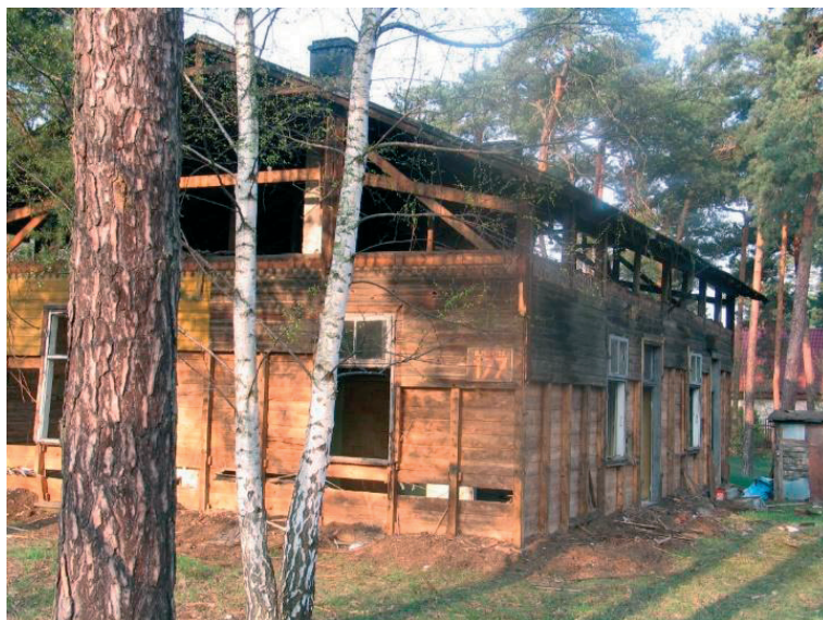
Fot. 1. Konstrukcja ścian parterowego budynku w tzw. stylu nadwiżżańskim w Warszawie – Radości (w trakcie rozbierania) – fot. A. Krajewski
