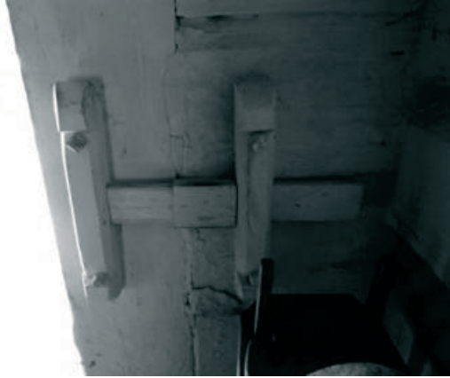
Fot. 3. Rekonstrukcja zamka drewnianego bezklucowego tzw. zasuwę do zamykania od wewnątrz budynku Chałupa z Korytkowa z 1798 r.
