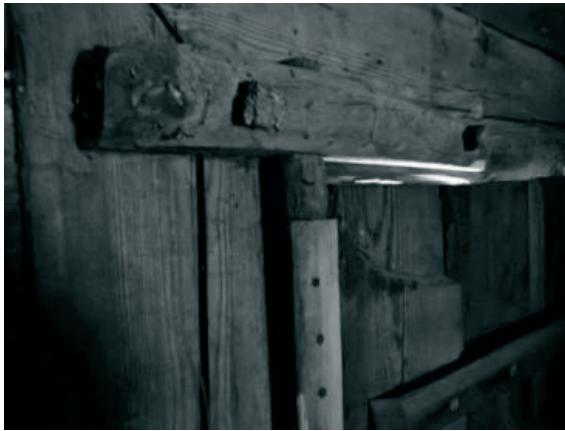
Fot. 1. Naprawa przez felkowanie bieguna drzwi sponowych. Chałupa z Korytkowa z 1798 r.
