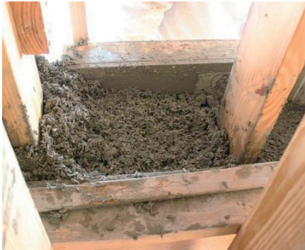
Rys. 3. Mieszanka ułożona w tymczasowym deskowaniu ściennym [6]
