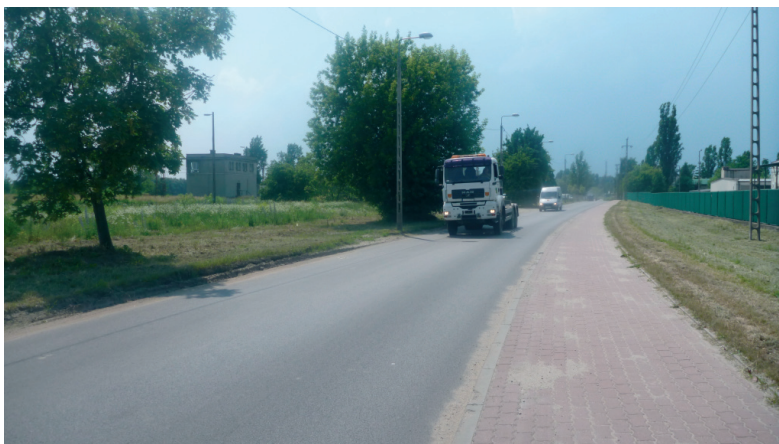
Fot. 3. Nawierzchnia drogi w technologii jednowarstwowej w trakcie eksploatacji.
