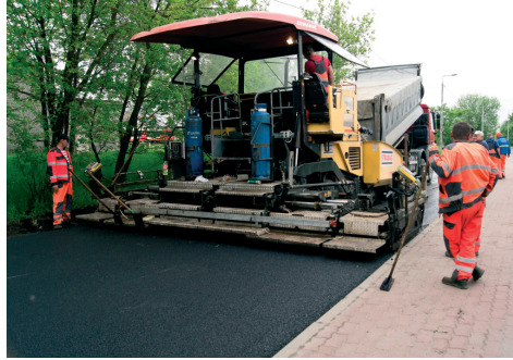
Fot. 2. Wbudowywanie i zagęszczenie warstwy
