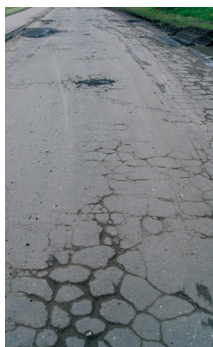
Fot. 1. Nawierzchnia drogi przed wykonaniem skropienia
