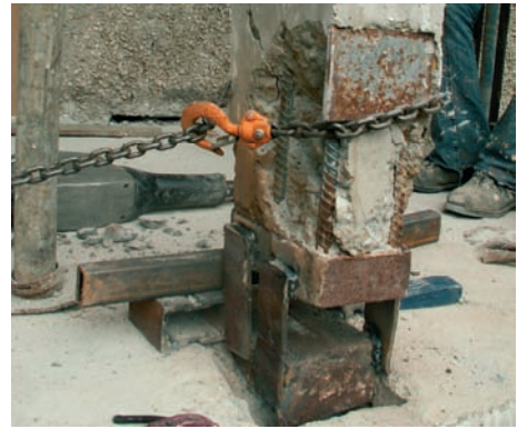
Rys. 11. Widok słupa po zakończeniu operacji prostowania i stabilizacji
