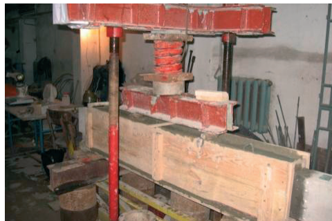
Rys. 4. Belka podczas obetonowywania
