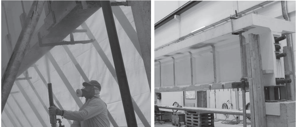
Rys. 3. Widok dźwigara podczas reprofilacji (lewa) i po wklejeniu bloków wypełniających (prawa)
