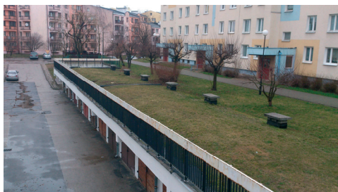
Rys. 3. Garaż z zielonymi dachami
