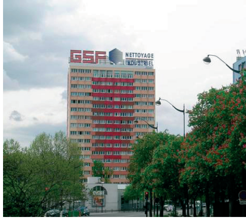
Rys. 6. Wieżowiec Tour Bois le Prêtre przed przebudową [10]
