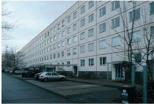
Rys. 4. Budynek przed przebudową [7]
