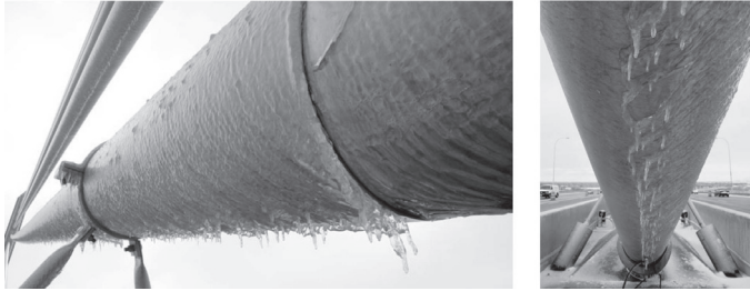
Rys. 1. Przykład oblodzenia cięgna mostu podwieszonoego Veteran's Glass City Skyway w Toledo w stanie Ohio, USA [4]
