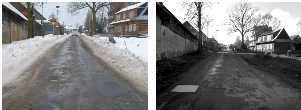
Rys. 1. Obraz drogi jako podstawa analizy estetyki – stan wyjściowy drogi w warunkach mokrej nawierzchni oraz w warunkach zimowych.
