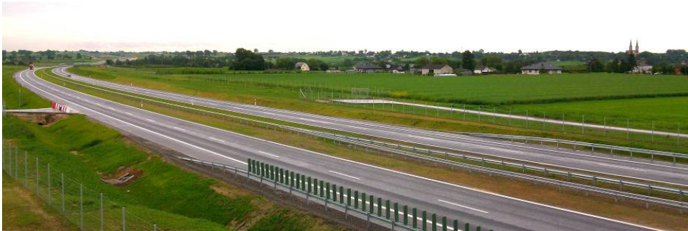
Rys. 2. S17 w okolicy miejscowości Garbów (fot. M.Kowal).
