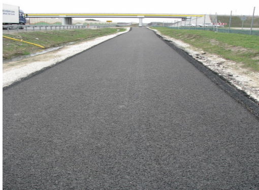
Rys. 3. Odcinek doświadczalny cichych nawierzchni
