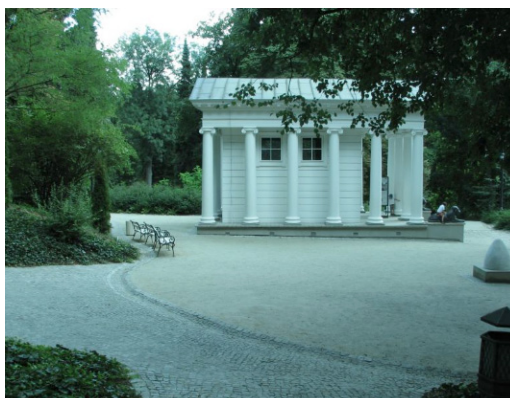
Rys. 8. Nawierzchnia wodoprzepuszczalna na terenie Łazienek Królewskich.
