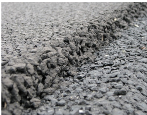
Rys. 4. Nawierzchnia wykonana w technologii asfaltu porowatego
