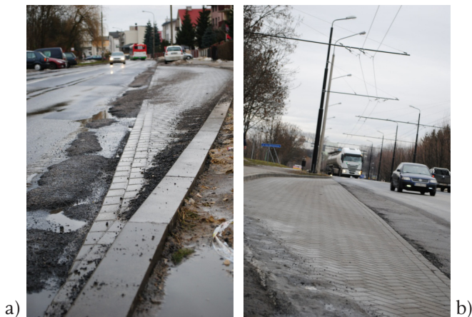
Fot. 4. Przebudowane zatoki autobusowe a) ul. Diamentowa b) ul. Romera [15].
