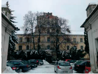
Rys. 1. Pałac Sobieskich. Widok od ulicy Bernardyńskiej (stan istniejący). Autor zdj. A. Jarocka-Mikrut
