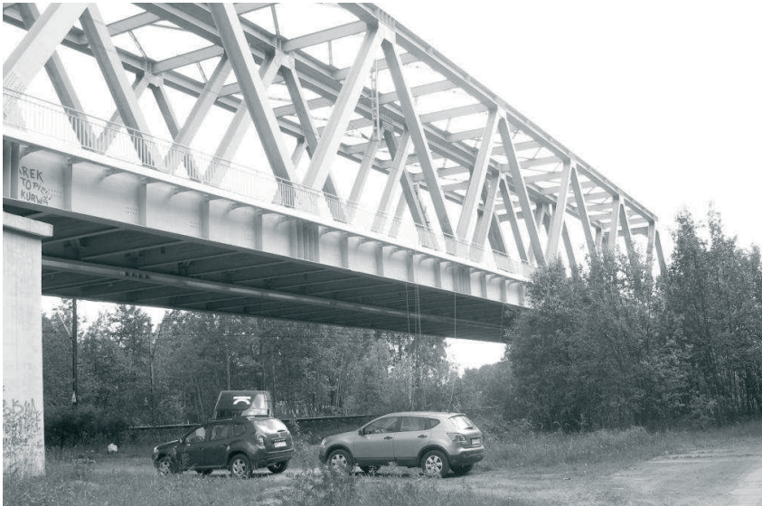
Rys. 1. Widok wiaduktu w czasie badań.
