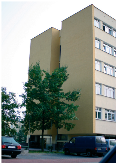
Fot. 2. Miejsce pod przyszły budynek WICA. Fot. J. Wrana, 2009. Phot. 2. Place for the future building of WICA.
