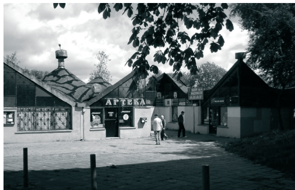
Rys. 7. Pawilon usługowo – handlowy, 2009, fot. Marcin Semeniuk Fig. 7. Sales and service pavilion.
