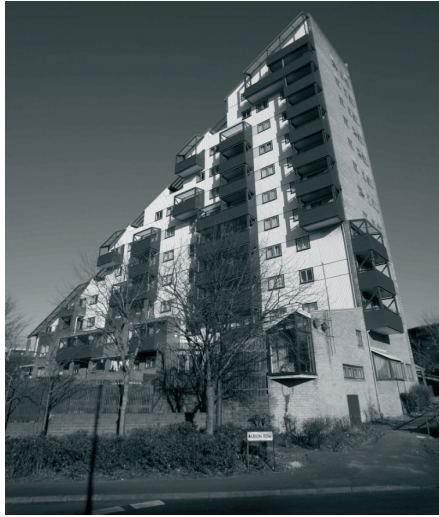
Rys. 17. Tom Collins House na osiedlu Byker Wall, źródło www.wikipedia.org Fig. 17. Tom Collins House on the Byker Wall estate.
