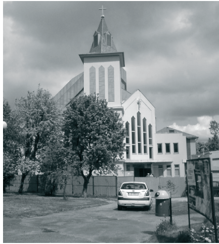
Rys. 13. Kościół, o bryle Formy Zamkniętej w przestrzeni Formy Otwartej. Kościół parafialny pw. Bł. Franciszka Frastiego. Fot. Marcin Semeniuk, 2009.
