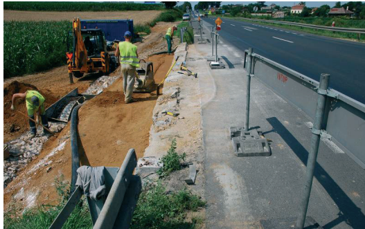
Fot. 5. Zagęszczanie zasyпки [10]. Phot. 5. Compaction of backfill [10].
