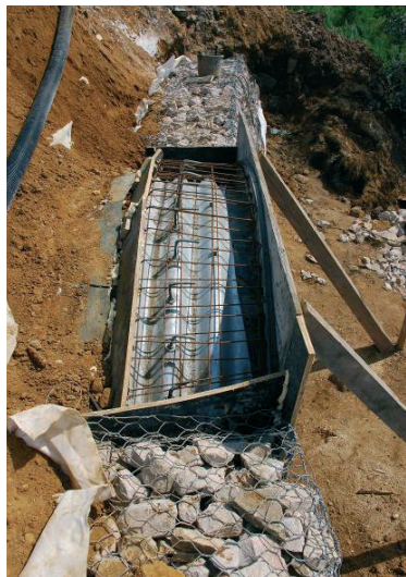
Fot. 6. Zbrojenie i deskowanie wieńca [10]. Phot. 6. Reinforcement and formwork element ending [10].
