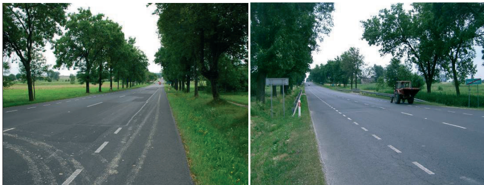
Fot. 2. Widok w ciągu drogi krajowej Nr 17 w kierunku m. Stary Zamość oraz w kierunku m. Zamość [10].
