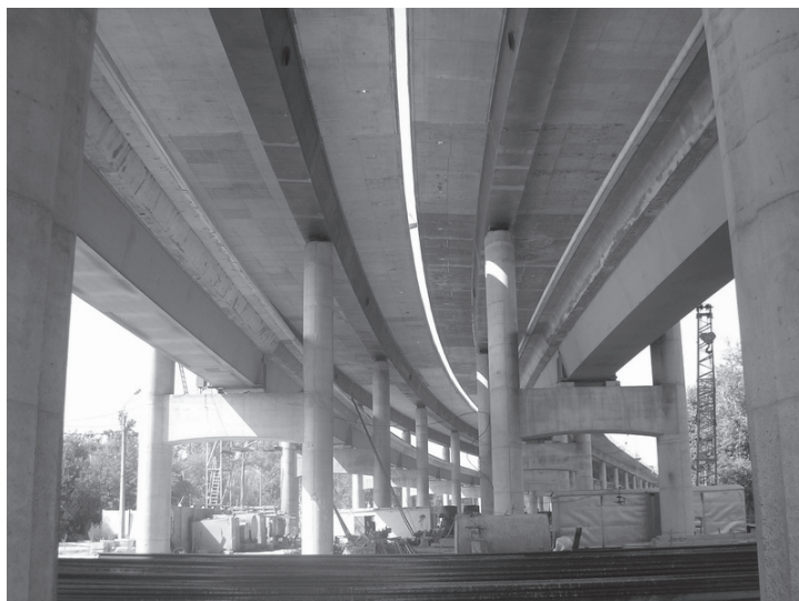
Fot. 16. Widok ogólny konstrukcji [5.1.4].
