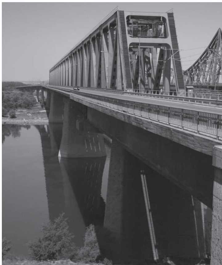
Fot. 5. Widok ogólny nowego mostu kolejowo – drogowego w miejscowości Cernavoda [5.1.5]. Phot. 5. Overall view of a new railroad bridge in Cernavoda [5.1.5].
