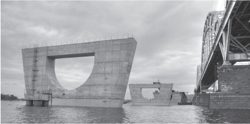
Fot. 14. Widok filarów z poziomu rzeki [5.1.4].
