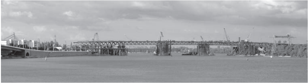
Fot. 17. Widok przęsła nurtowego w trakcie budowy [6].
