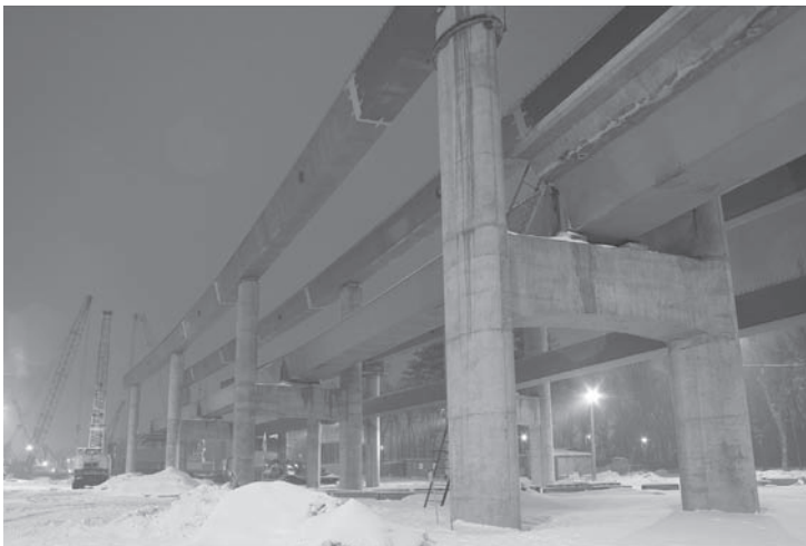
Fot. 15. Widok mostu Podolskiego w trakcie budowy [5.1.4].
