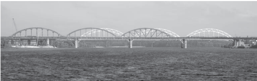
Fot. 13. Widok mostów od strony koryta rzeki [6]. Phot. 13. Panoramic view of two Darnitcki bridges [6].
