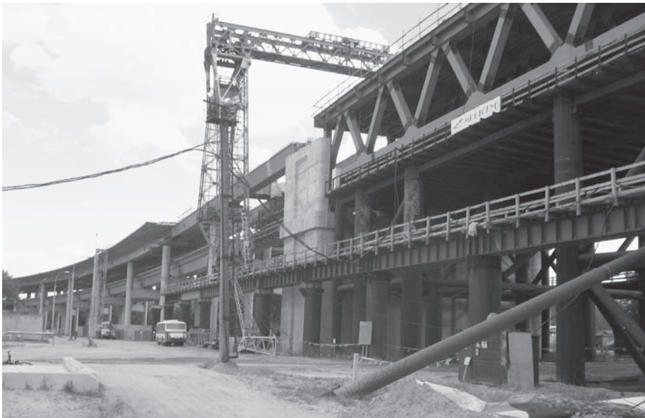
Fot. 18. Moment zmiany typu konstrukcji przęsła głównego [6].
