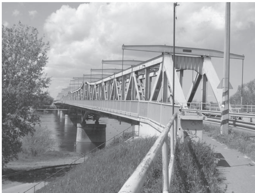
Fot. 9. Widok mostu z perspektywy pieszego [5.2.1].
