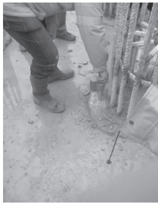
Fot. 3. Badanie wytrzymałości betonu metodą sklerometryczną. Phot. 3. Concrete strength testing by sclerometric method.
