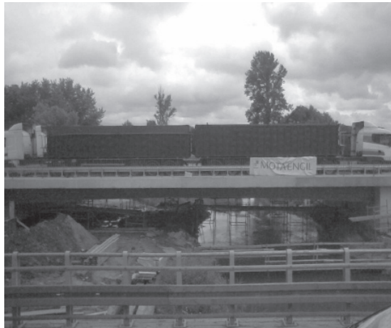
Fot. 5. Próbné obciążenie 16.06.2009. Phot. 5. Bridge proof load 16.06.2009.
