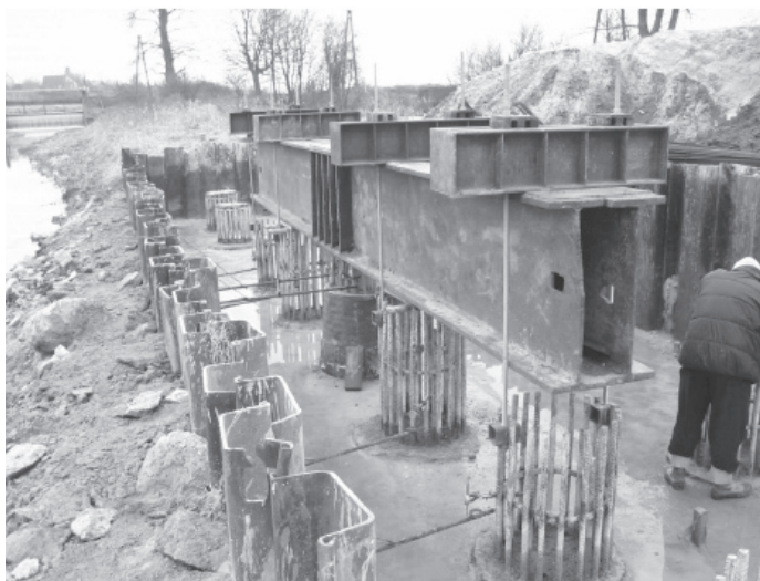
Fot. 1. Próbne obciążenie pala. Phot. 1. Pile proof test.
