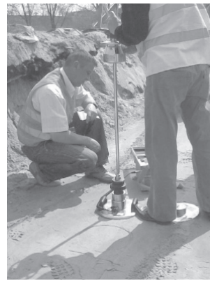
Fot. 4. Badanie zagęszczenia płytą dynamiczną. Phot. 4. Soil consolidation testing by dynamic plate.
