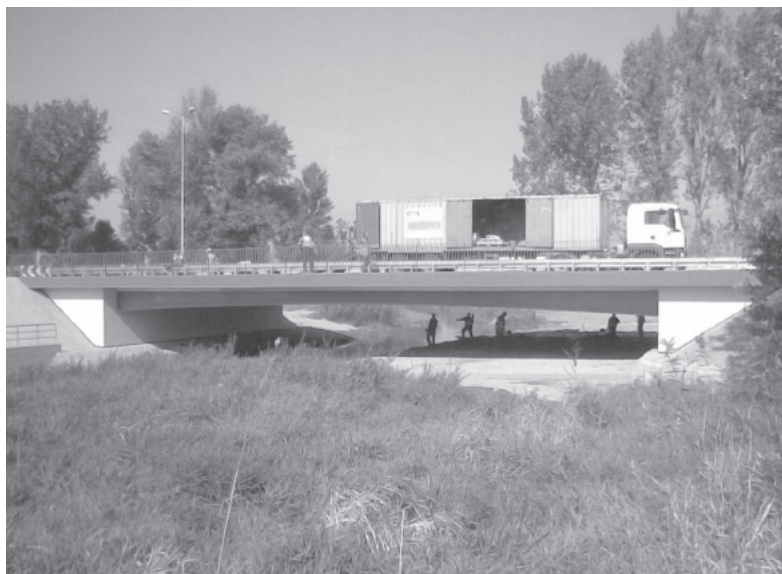
Fot. 6. Widok mostu od strony południowej (górnej wody). Phot. 6. South-side bridge view.
