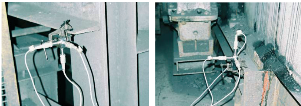
Rys. 1. Sposób zamocowania akcelerometrów. Fig. 1. Accelerators constraining fastening.
