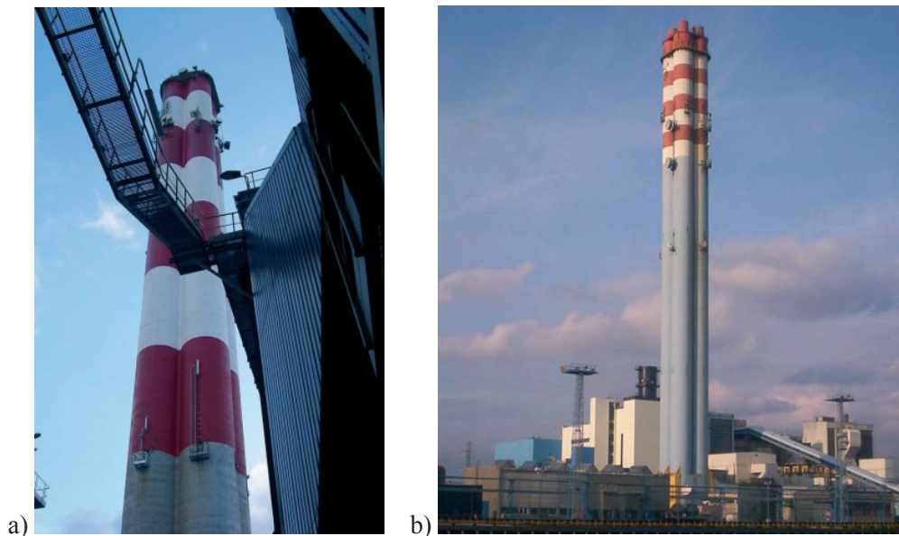
Rys. 6. Kominy czteroprzewodowe elektrociepłowni: a – w Gdyni, b – w Lublinie.
