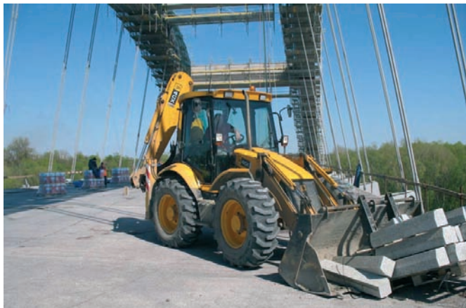
Rys. 18. Koparko-ładowarka wymuszająca drgania. Fig. 18. A digger forcing vibrations.
