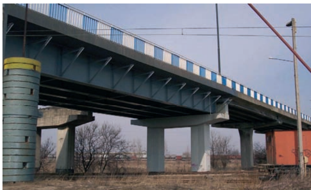
Rys. 14. Wiadukt na ulicy Grygowej w Lublinie.
