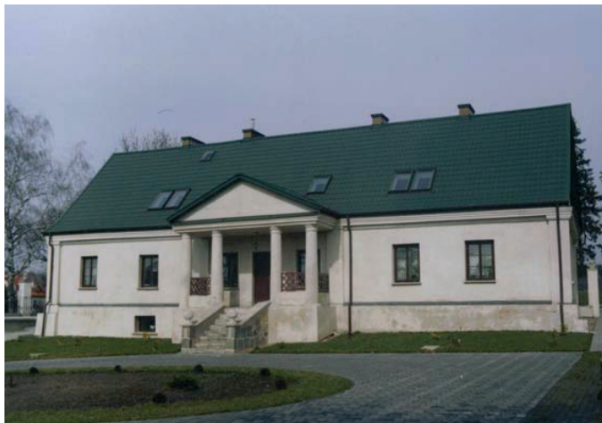
Fot. 3. Elewacja ogrodowa – 2008 rok.
