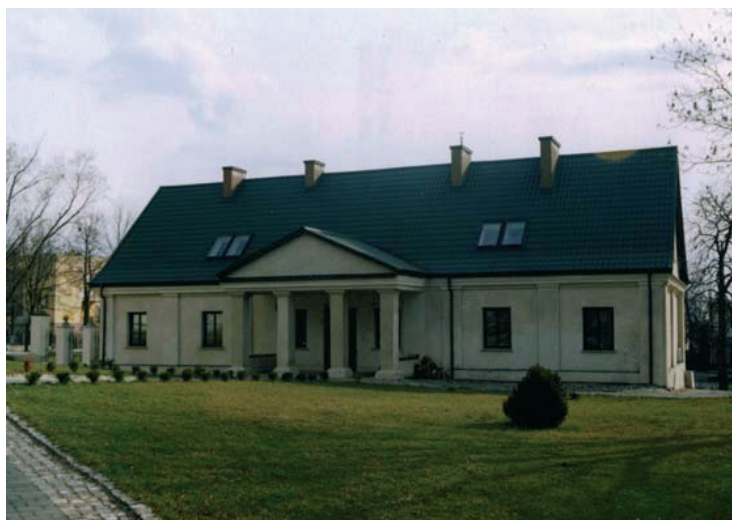
Fot. 2. Elewacja frontowa – 2008 rok.
