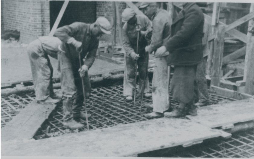
Fot. 5. Zagęszczanie betonu w stropie żebrowym (ok. 1929).
