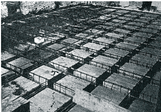
Fot. 7. Strop kasetonowy, widok na deskowanie i zbrojenie przed ułożeniem mieszanki betonowej (Wawel).
