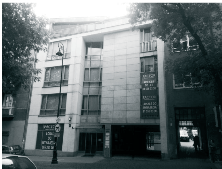
Rys. 2. Budynek biurowca przy ul. Gabriela Narutowicza 55b w Lublinie. (fot. Autor)
