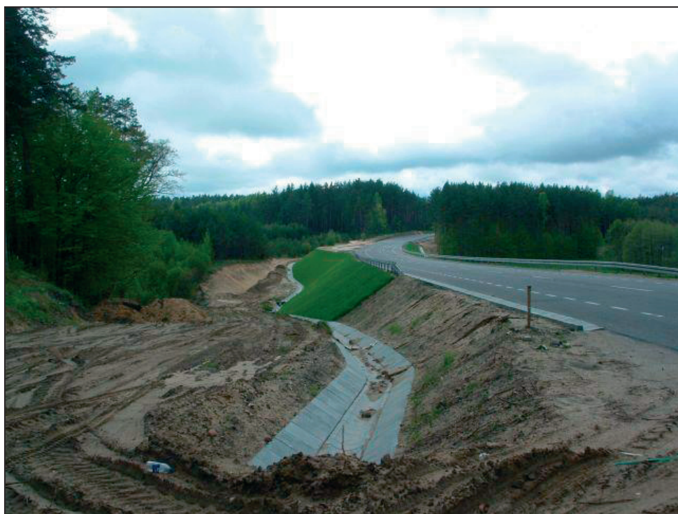
Rys. 2. Układanie darni i odwodnienie korpusu drogi (źródło: http://archiwum.parp.gov.pl/infra2000/0008_01_03.php )
