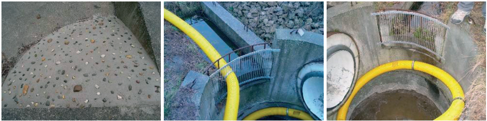
Fot. 9-11. Docelowe elementy uciezkowe ze zbiorników i studni wpadowych oraz przegęszczenie kraty wlotowej
