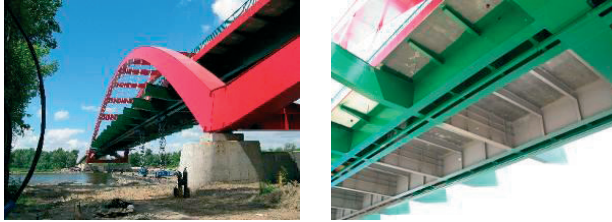
Rys. 6. Widok mostu w Puławach: a) widok boczny, b) widok od dołu
