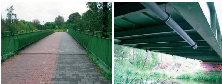
Rys. 1. Kładka w sąsiedztwie ulicy Janowskiej w Lublinie: a) widok z perspektywy pieszego b) widok pomostu od dołu
