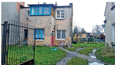
Rys. 17. ul. Młyńska 8, front budynku
