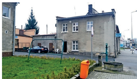
Rys. 18. ul. Wrocławska 13, 15, front budynków
