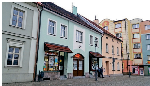
Rys. 13. ul. Rynek 6, front budynku
