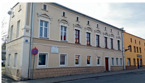
Rys. 6. ul. Kolejowa 20, front budynku
