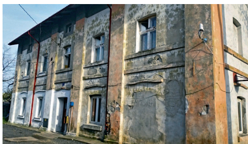
Rys. 8. ul. Zaulek Fabryczny 1, front budynku
