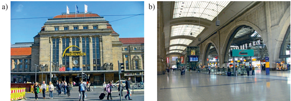
Rys. 1 a i b. Budynek dworca w Lipsku oraz wnętrze hali głównej z widocznym zejściem na poziomy centrum handlowego; źródło: fot. B. Czarniecki
