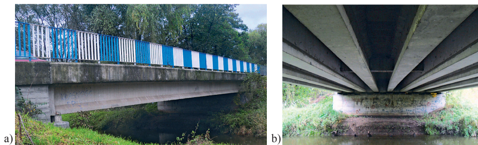
Rys. 3. Most na ul. Wł. Jagiełły a) widok z boku b) widok od spodu na belki i poprzecznicę
