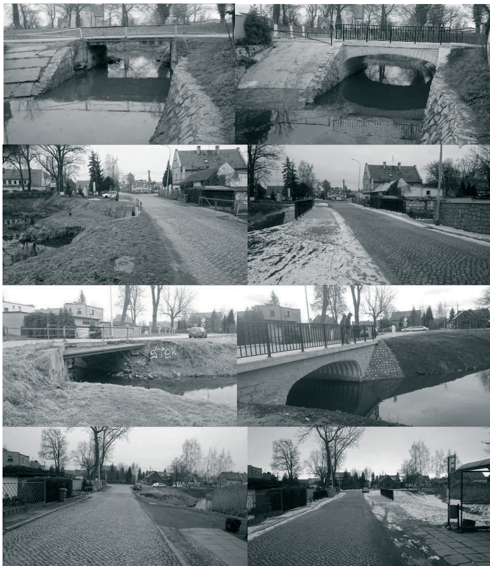
Rys. 6. Most drogowy w Żórawinie – przed i po przebudowie
