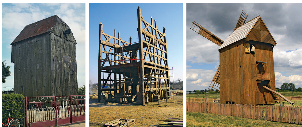
Fot. 3. Wiatrak ze Zblyczyc przed (lipiec 1998 r.), w trakcie (07.03.2012 r.) i po zakończeniu prac konserwatorskich (sierpień 2012 r.), fot. F. Tomaszewski.
