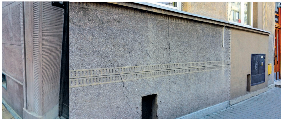
Fot. 3. Ryflowane tynki kamieniarskie
