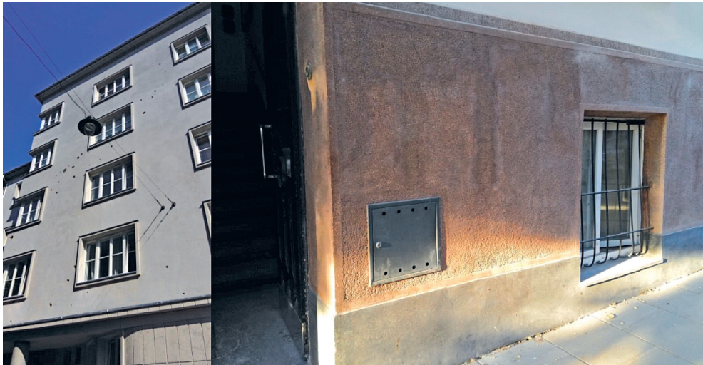
Fot. 5. Podczas remontu zachowano oryginalne tynki wraz z ich wojennymi uszkodzeniami. Zdarzają się próby scalenia uzupełnień tynku kamieniarskiego – pozytywny przykład poszanowania historycznego wystroju
