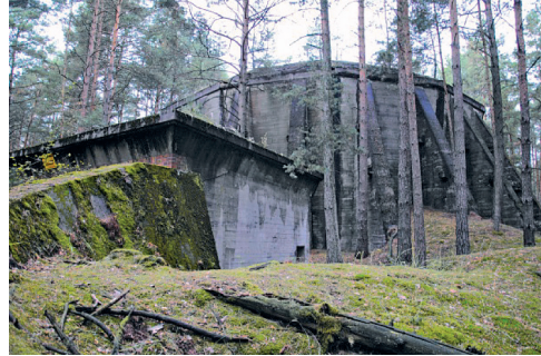
Fot. 8. Jeden z silosów o nieznanym przeznaczeniu
