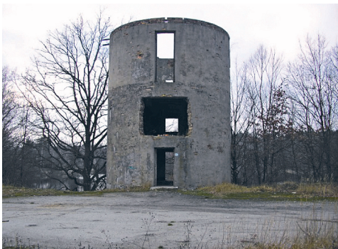
Fot. 9. Wieża basenu uzdatniania wody
