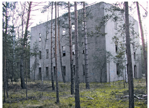
Fot. 10. Budynek przy basenie uzdatniania wody
