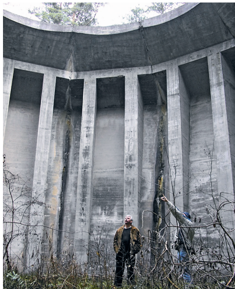
Fot. 3. Silos o nieznanym przeznaczeniu
