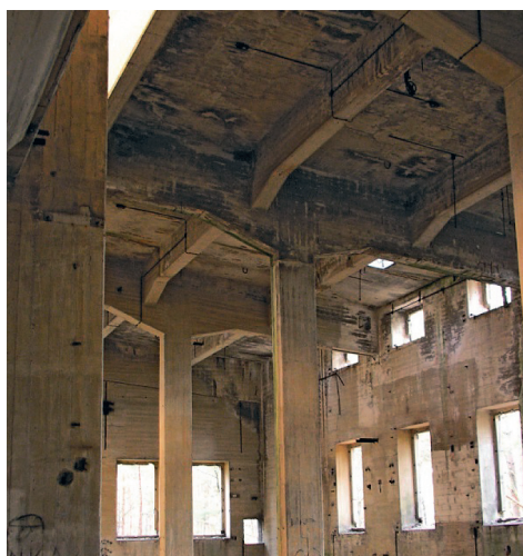
Fot. 5. Wnętrze budynku elektrociepłowni
