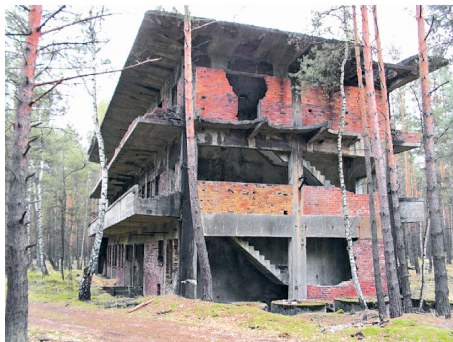
Fot. 2. Budynek laboratorium
