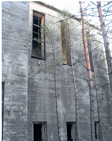
Fot. 4. Budynek elektrociepłowni
