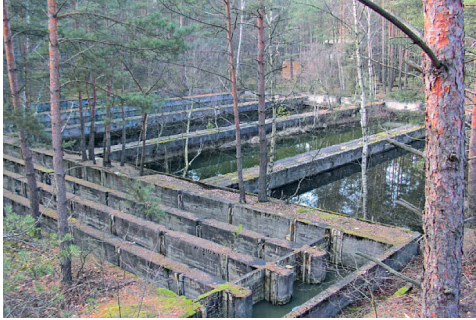
Fot. 7. Oczyszczalnia ścieków
