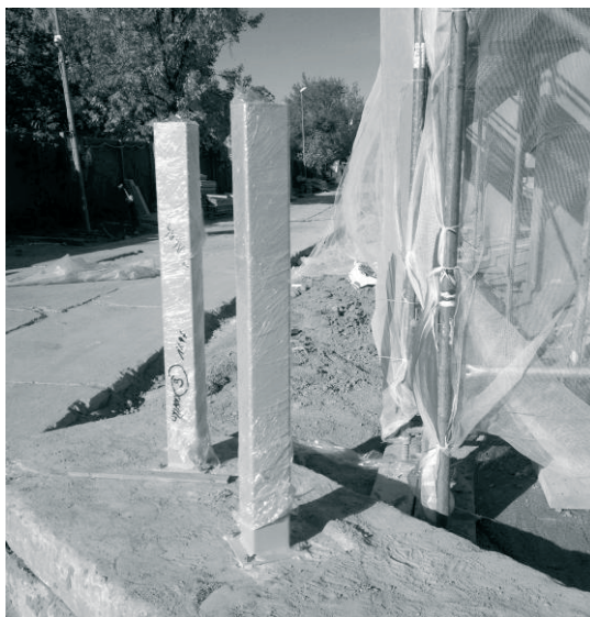
Rys. 3. Odbojnice słupowe w narożu rusztowania w sąsiedztwie drogi tymczasowej (Fot. Opeus)
