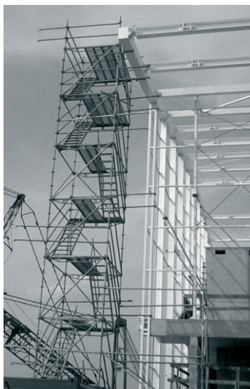
Rys. 2. Kotwienie w postaci obejm wykonanych z rur uniwersalnych (Fot. Altrad Mostostal)
