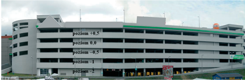
Rys. 1. Widok ogólny garażu z oznaczeniem poziomów kondygnacji
