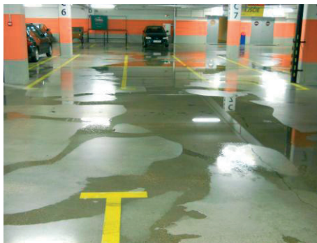
Rys. 5. Tworzące się kałuże na stropie poziomym +0,5 w trakcie przeprowadzania próby wodnej
