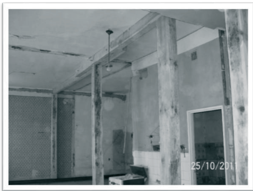
Rys. 2. Wykonanie nakazu podstemplowania stropu budynku
