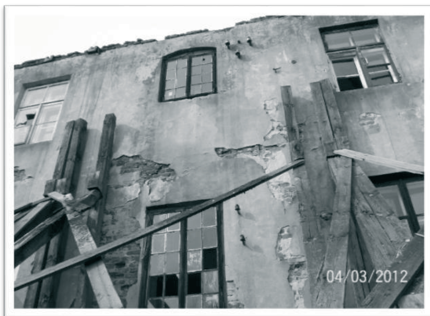
Rys. 3. Wykonanie nakazu podstemplowania ściany w budynku wyłączonym z użytkowania
