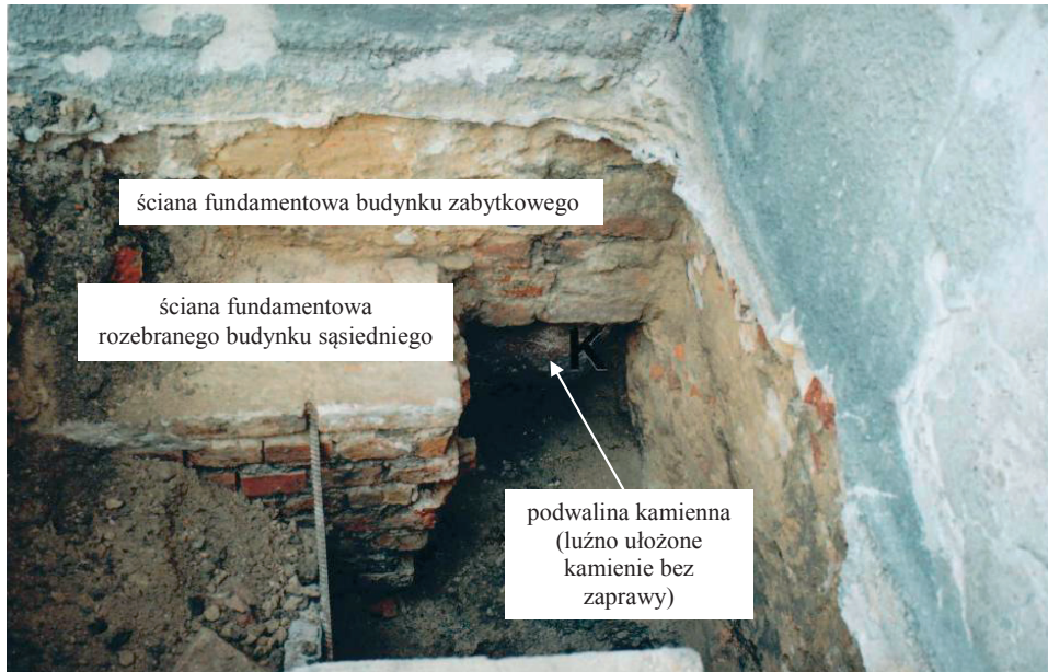
Rys. 4. Widok na fundament budynku zabytkowego i pozostałą w gruncie ścianę rozebranego budynku
