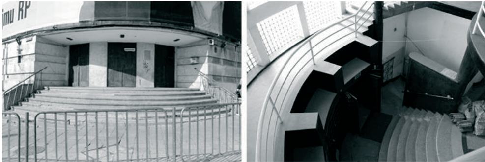
Rys. 6. Po lewej: Główne wejście do budynku. Po prawej: Wewnętrzne schody przy wejściu (fot. własne, 2015 r)
