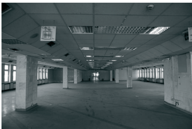
Rys. 6. Wnętrze najwyższej kondygnacji budynku PDT ukazujące układ konstrukcyjny sprzyjający adaptacji na nową funkcję użytkową. (fot. Autor)
