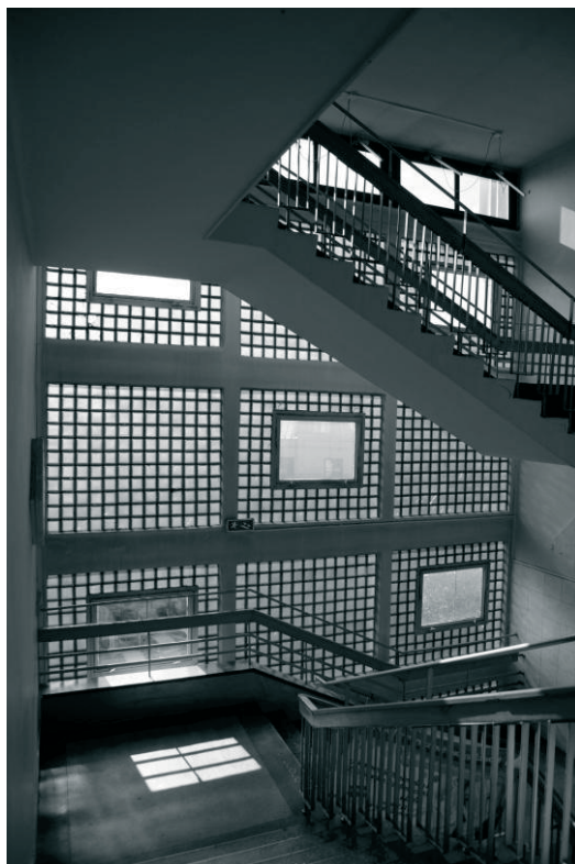
Rys. 5. Doświetlenie południowej klatki schodowej za pomocą luksferów. (fot. Autor)
