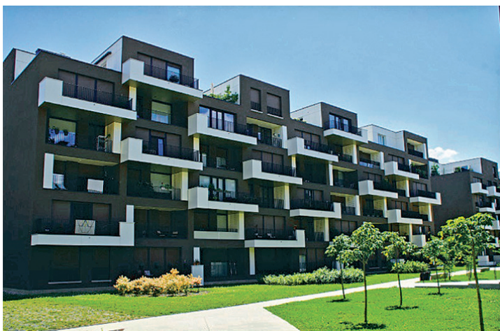
Fot. 16.–18. Architektura mieszkaniowa integrująca miejską przestrzeń. Fot. Wacław Seruga 2017
