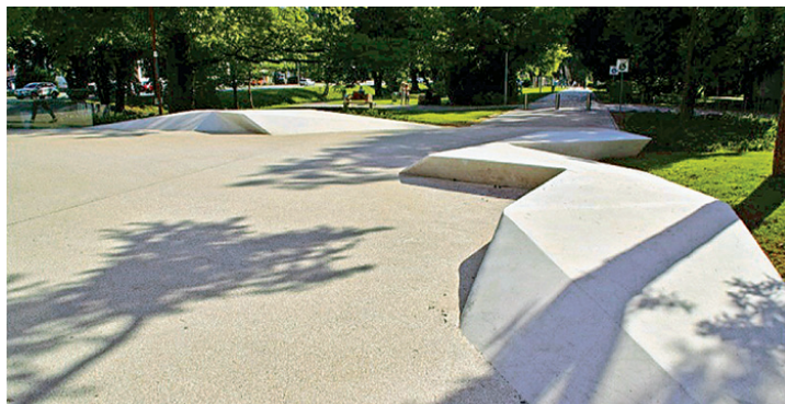
Fot. 1.–2. Promenada w Velenje, Słowenia. Kreatywnie ukształtowana posadzka z betonowych płyt pieszej promenady. Fot. Waław Seruga 2017
